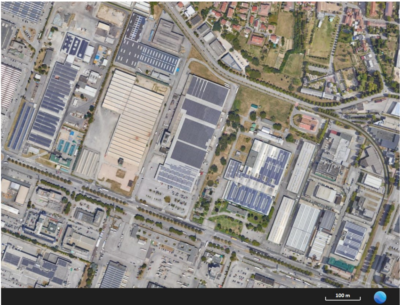
Figura 4. Impianti FVT nella zona industriale di Padova
