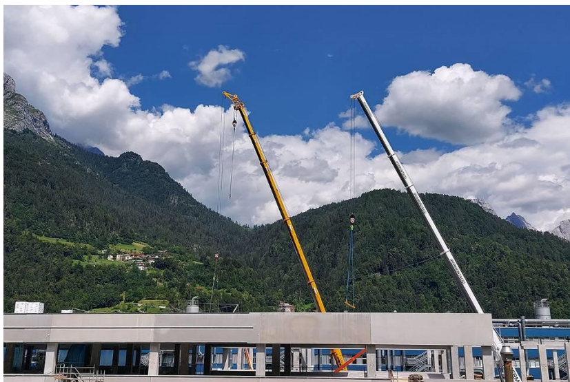
N. 15: ampliamento di un insediamento industriale ad Agordo (BL) per la produzione di occhialeria, realizzato tra il 2019 ed il 2020 per una superficie complessiva di quasi 1,6 ettari di cantiere, 5.900 m 2 dei quali occupati dai nuovi edifici e 4.300 m 2 occupati da aree impermeabilizzate per piazzali, parcheggi e viabilità (immagine 2018 in alto, immagine Triplesat 2020 in centro, fotografia della realizzazione del nuovo fabbricato in basso).
