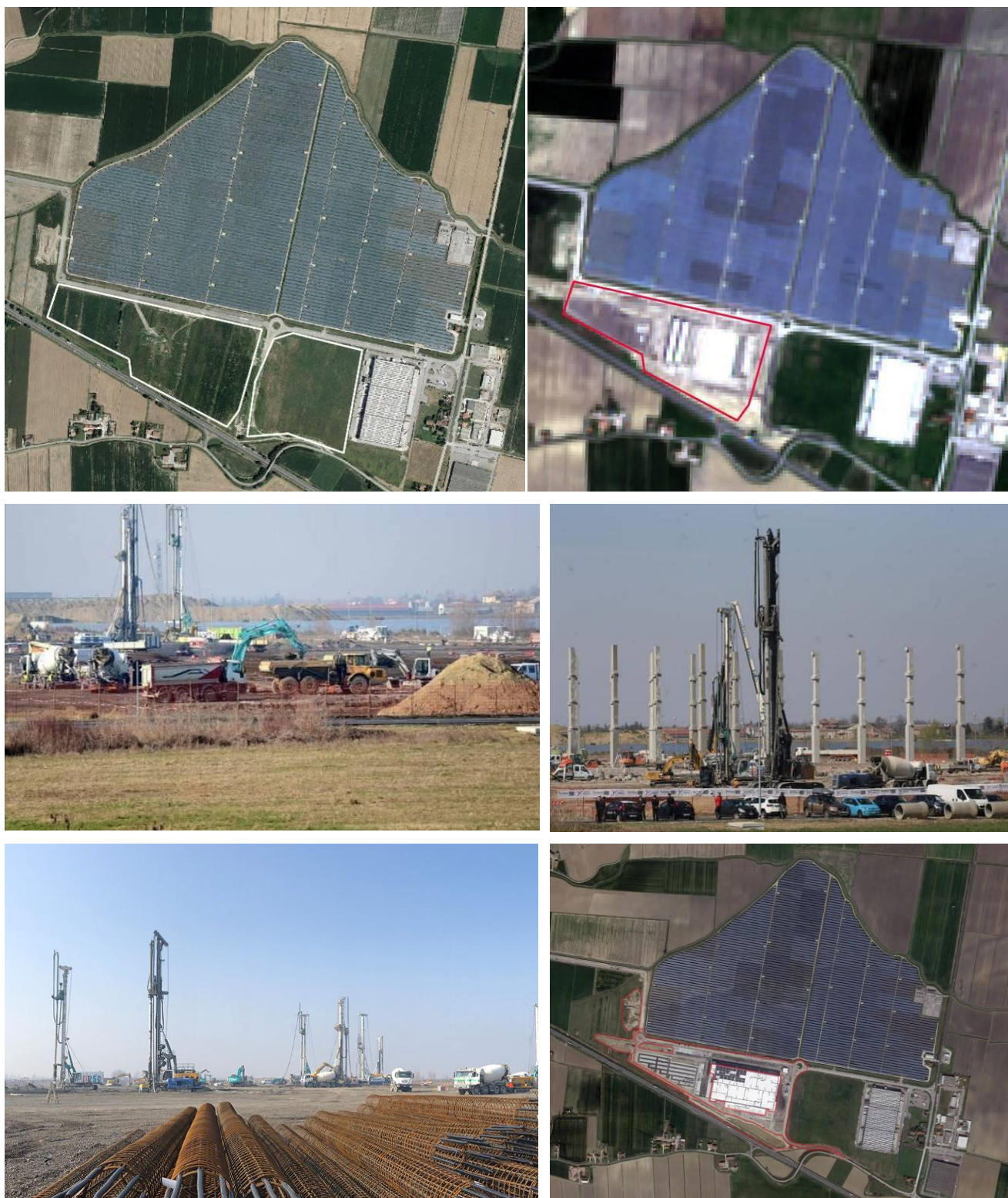
N. 2: Magazzino di un colosso statunitense dell'e-commerce a Castelguglielmo e San Bellino (RO); nel 2019 è stato costruito un magazzino di 53.200 m 2 su 4 livelli per un'altezza complessiva di 15m (immagine 2018 in alto a sinistra e aprile 2019 in alto a destra; foto del cantiere nei primi mesi del 2019 in basso). Nel 2020 (immagine in basso a destra) risultano piazzali e viabilità per ulteriori 123.300 m 2 , complessivamente risultano impermeabilizzati un totale di circa 17,7 ha. Come si può notare dalle varie immagini satellitari il sito è ubicato a sud del grande parco fotovoltaico di San Bellino (160 ha occupati da pannelli).
