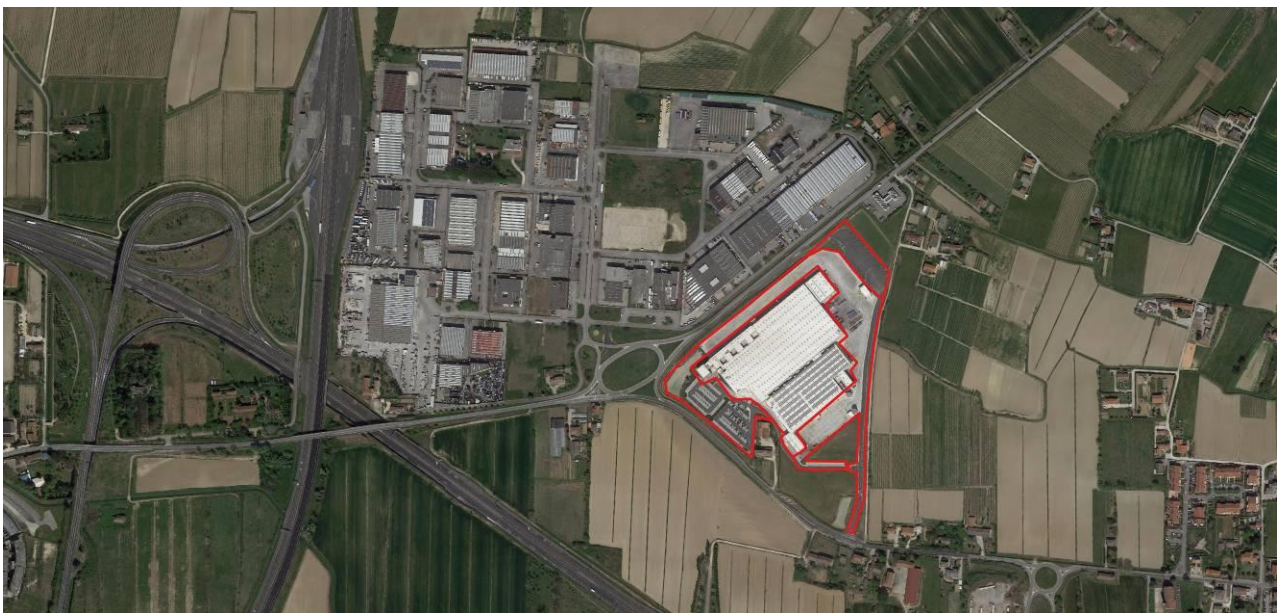
N. 7: Nuova area industriale a Bonisiolo (Mogliano Veneto - TV): con un cantiere di circa 121.000 m 2 , risultano costruiti 45.000 m 2 destinati a depositi e uffici e 49.000 m 2 di aree per parcheggi e viabilità per un totale di circa 94.000 m 2 di aree impermeabilizzate per un gruppo della distribuzione organizzata operante nel commercio alimentare e non del Nord-Est (immagine 2017 in alto a sinistra e 2018 a destra; in basso immagine 2020).
