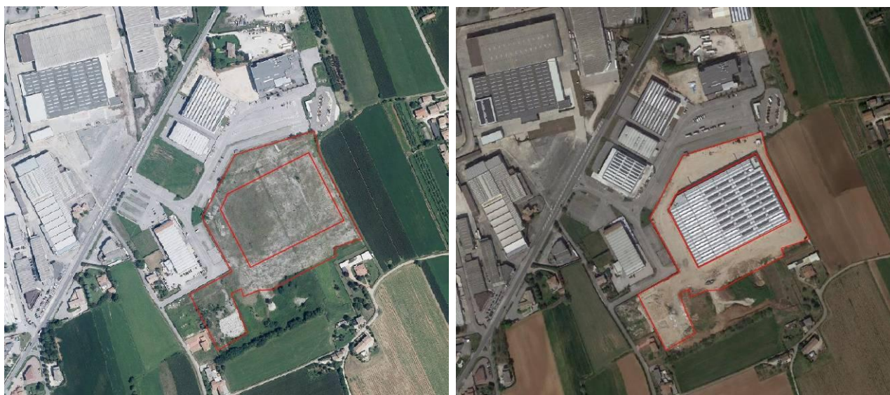
N. 17: Insediamento industriale per una ditta italiana leader nel settore dell'abbigliamento per motociclismo a Caerano San Marco (TV) di nuova realizzazione con un cantiere di 49.600 m 2 , di cui 21.100 m 2 consumati per la realizzazione dell'edificio stesso e 11.500 m 2 impermeabilizzati ad ora, ma a opera conclusa saranno di più, per consentire la viabilità dei mezzi, per realizzazione di piazzali e parcheggi (immagine 2018 a sinistra, 2020 a destra).
