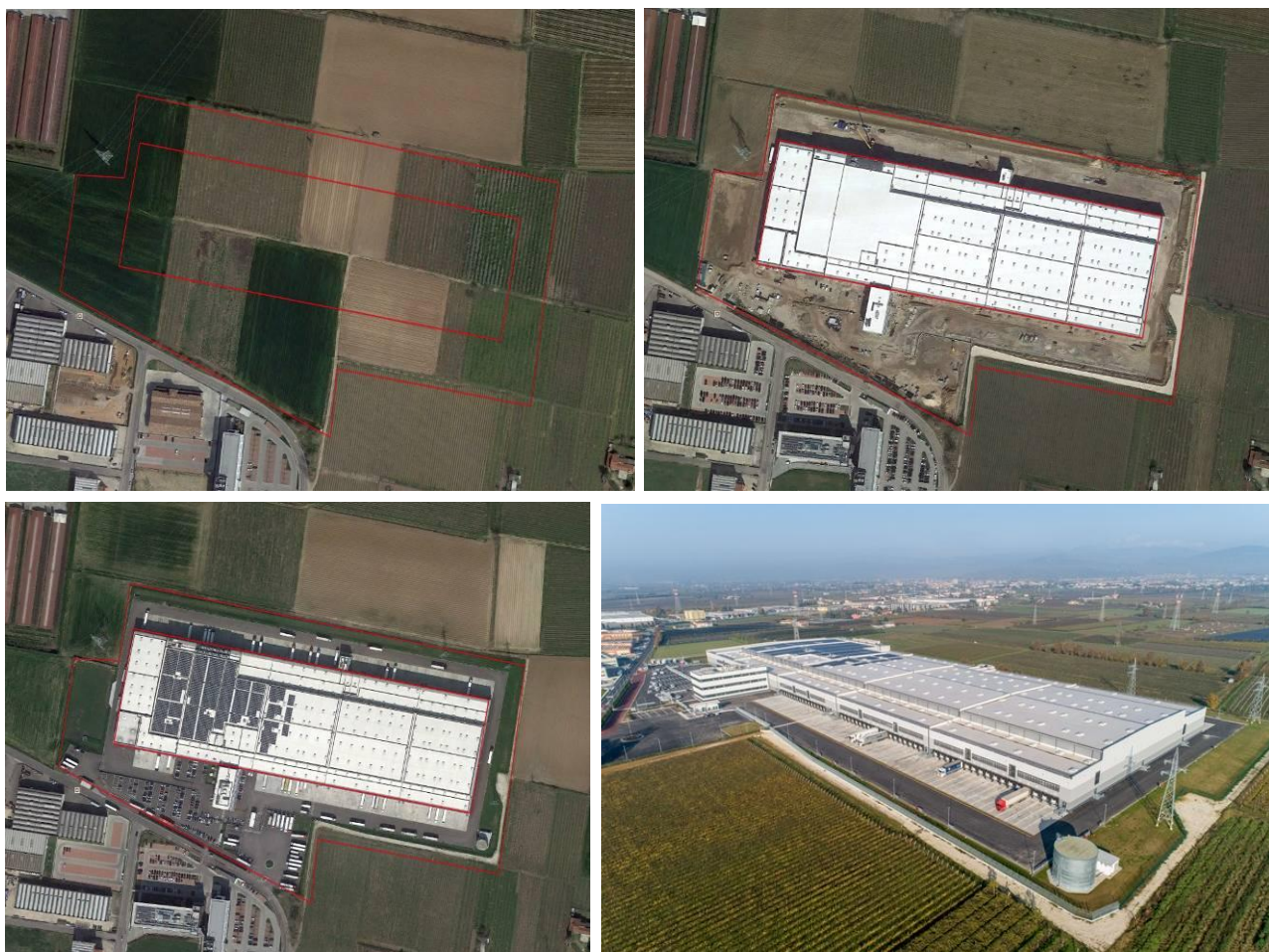
N. 4: Costruzione ad Arcole (VR) del magazzino per una catena di supermercati di un marchio discount tedesco con una superficie di cantiere di 112.800 m 2 , con un'area cementata di 51.400 m 2 per parcheggi e nuova viabilità per la circolazione dei mezzi all'interno dell'area e 48.500 m 2 di edifici (immagine del 2016 in alto a sinistra, del marzo 2018 in alto a destra, del 2020 in basso a sinistra, rendering in basso a destra).
